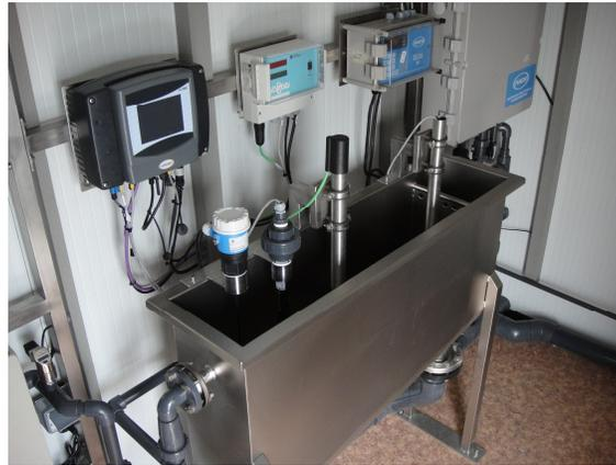
**Figura 3: sondas de medida de pH, SAC y oxígeno disuelto**
